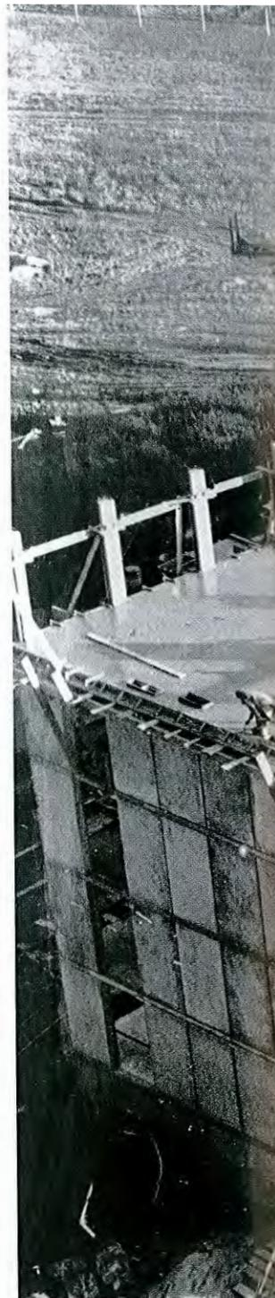
Le chantier des Grandes Terres à Marly-le-Roi. Dans l'ossature porteuse en béton armé, ici en construction, viendront se loger des panneaux de façade légers, réalisés en usine.
